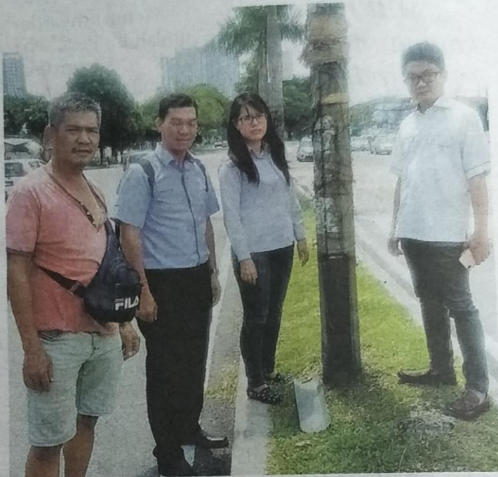
Siew Ki (dua dari kanan) melihat penutup tiang lampu yang terbuka akibat perbuatan vandalisme di Persiaran Damai Perdana.
